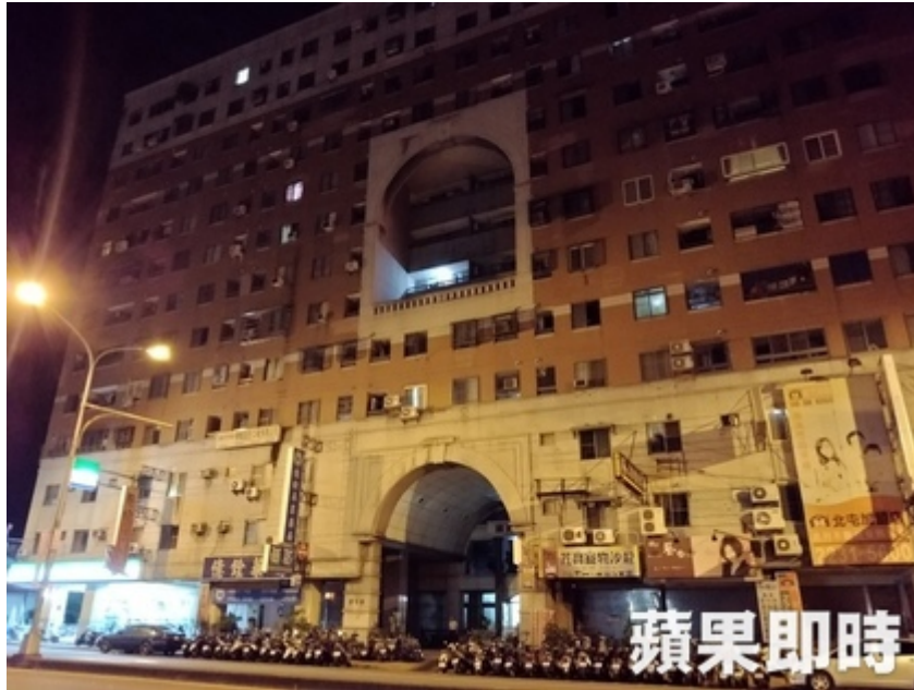
台中市北屯路上一棟住宅大樓，凌晨驚傳一氧化碳中毒，造成莊姓一家四人送醫。黃士航攝
