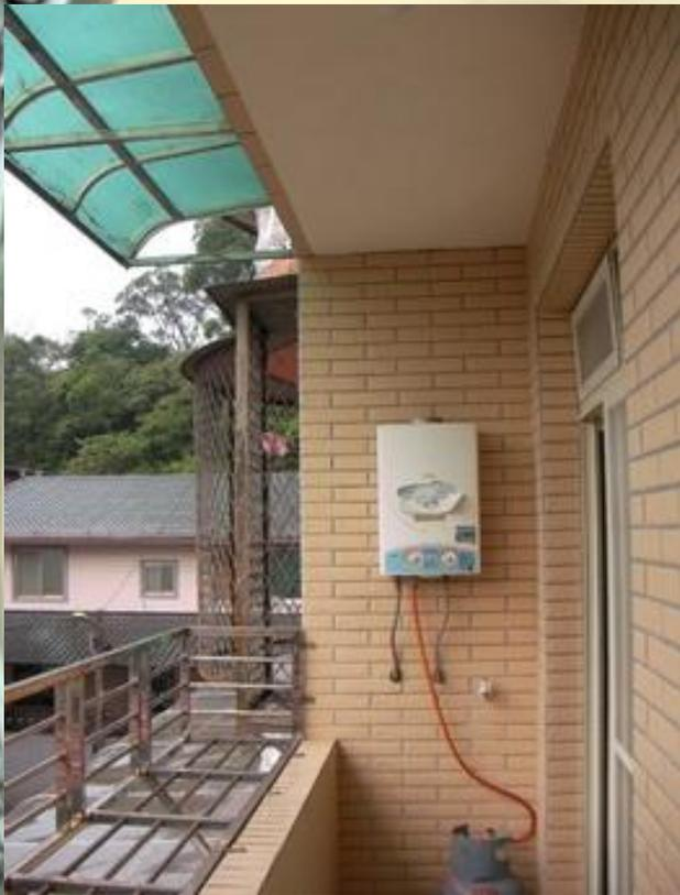
屋外型熱水器限制安裝在室外通風良好處所，且周圍不能有雜物阻擋通風
