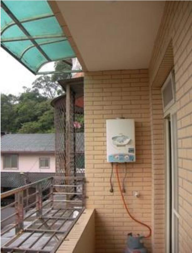
屋外型熱水器限制安裝在室外通風良好處所，且周圍不能有雜物阻擋通風
