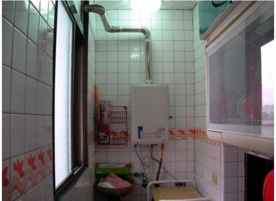
熱水器安裝室內，就必須使用強制排氣型
